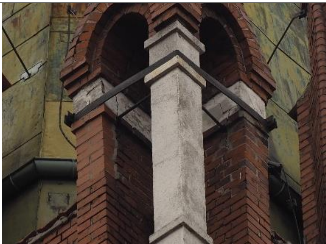
5. Kętrzyn; kościół parafialny pw. Św. Katarzyny Aleksandryjskiej – wieża, szczyty elewacji południowo-wschodniej i północno-wschodniej. Przemurowania sterczyn cegłą klinkierową.
