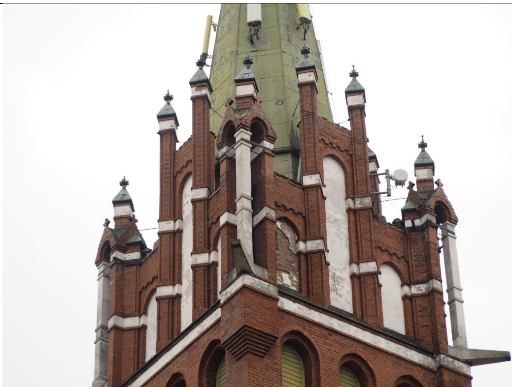
2. Kętrzyn; kościół parafialny pw. Św. Katarzyny Aleksandryjskiej – wieża, szczyty elewacji południowo-zachodniej i północno-zachodniej. Zabrudzenia wątków murowych; ubytki wypraw.
