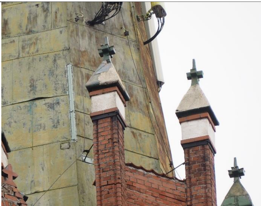
6. Kętrzyn; kościół parafialny pw. Św. Katarzyny Aleksandryjskiej – wieża, szczyt elewacji północno-wschodniej. Ubytki spoinowań; odkształcenia sterczyn; prowizoryczne uzupełnienia nakryw.
