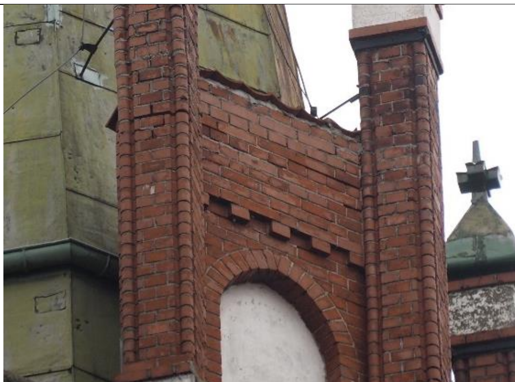
9. Kętrzyn; kościół parafialny pw. Św. Katarzyny Aleksandryjskiej – wieża, szczyt elewacji północno-wschodniej. Wylewki cementowe, pokrycie stopni dachówką.
