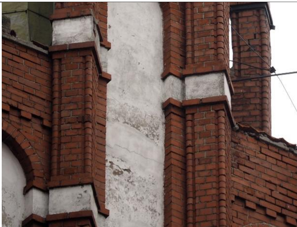
8. Kętrzyn; kościół parafialny pw. Św. Katarzyny Aleksandryjskiej – wieża, szczyt elewacji południowo-wschodniej. Uzupełnienia, przemalowania wypraw.
