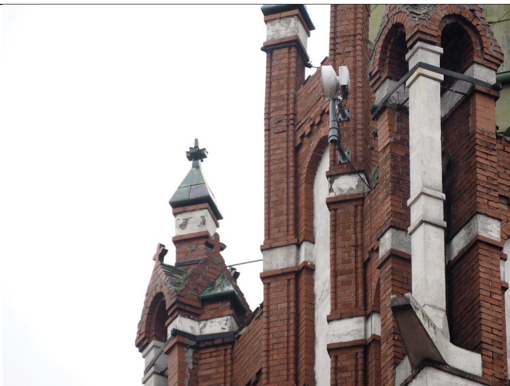
7. Kętrzyn; kościół parafialny pw. Św. Katarzyny Aleksandryjskiej – wieża, szczyty elewacji południowo-zachodniej i północno-zachodniej. Przemalowania wypraw i elementów kamiennych.
