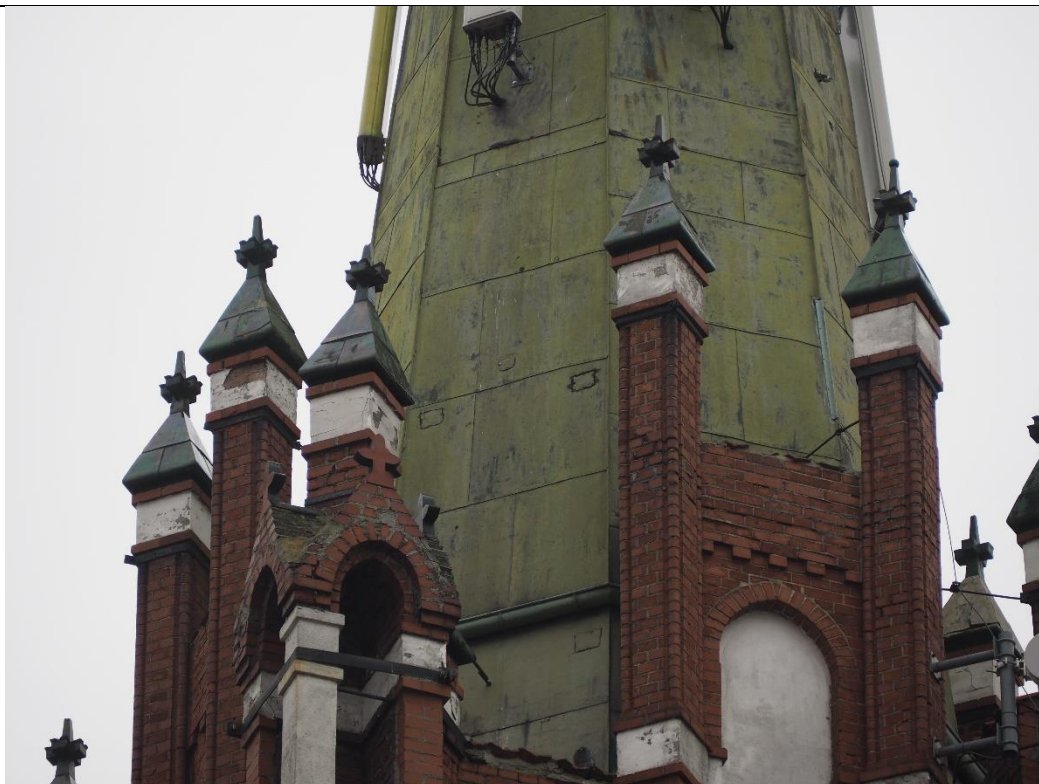
3. Kętrzyn; kościół parafialny pw. Św. Katarzyny Aleksandryjskiej – szczyty elewacji południowo-zachodniej i północno-zachodniej. Odspojenia, spękania, ubytki wypraw w obrębie opasek sterczyn.
