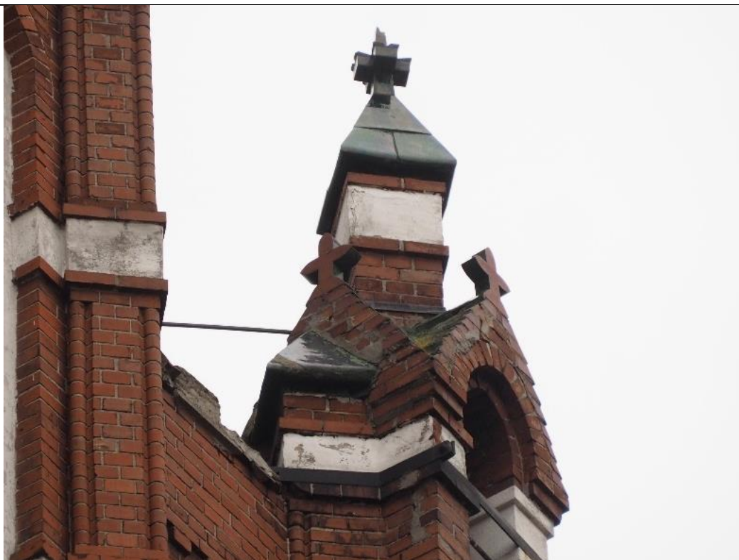
4. Kętrzyn; kościół parafialny pw. Św. Katarzyny Aleksandryjskiej – wieża, szczyt elewacji północno-zachodniej. Przemurowania, uzupełnienia nakryw sterczyn.
