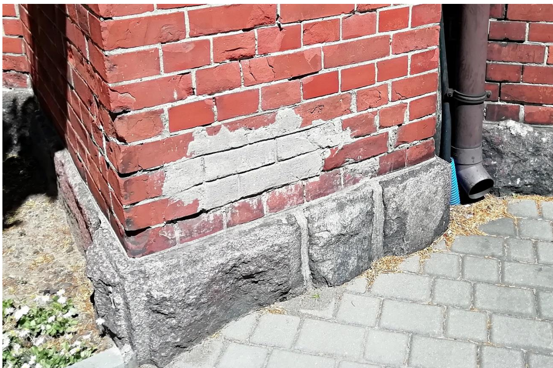
Źle dobrane uzupełnienia ubytków w ceglach.
