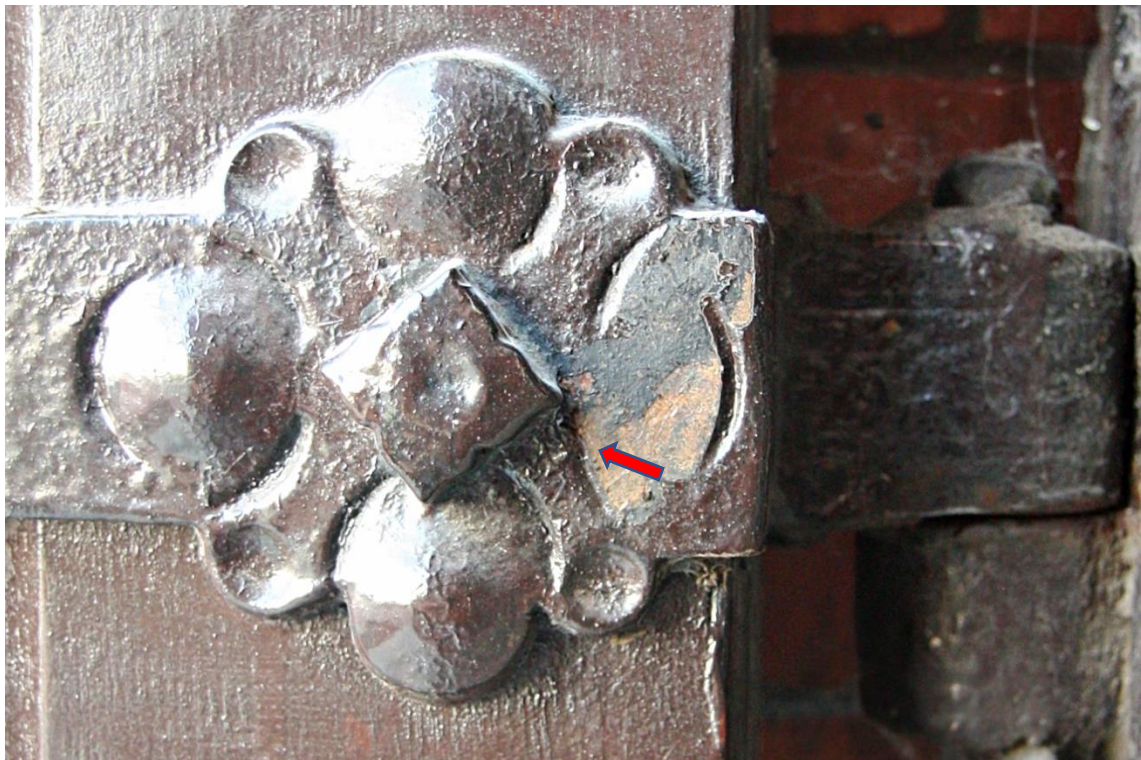
Fragment zawiasu drzwi głównych. Wykonano odkrywkę. Bezpośrednio na metalu ujawniono czarną farbę. Zaznaczono miejsce pobrania.
