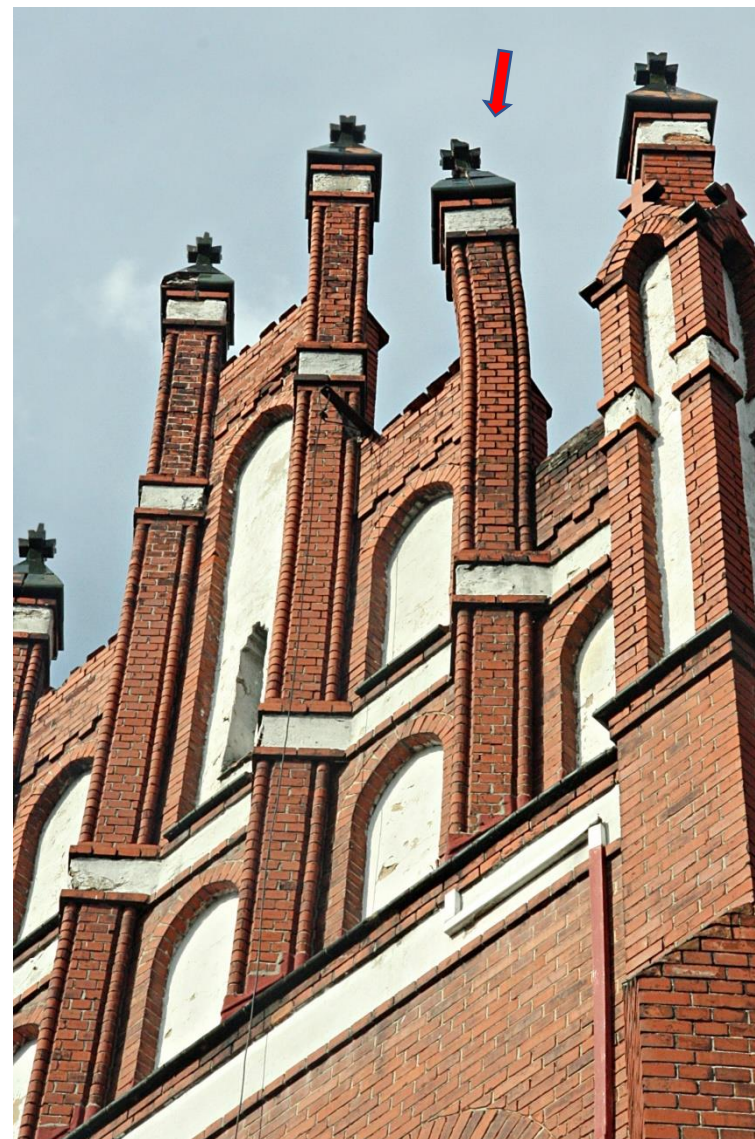
Niektóre ze sterczyn są przechylone i w razie silnego wiatru grożą zawaleniem.
