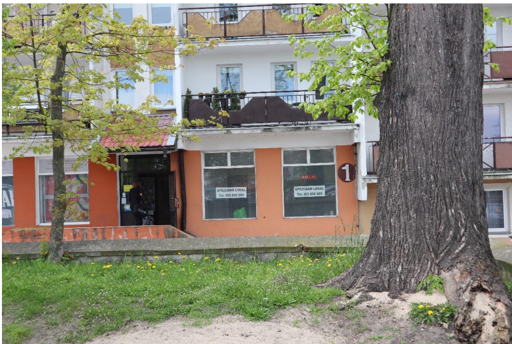
Fot. 1. Przykład lokalu użytkowego usytuowanego na parterze budynku wielorodzinnego typu blok, ul. Kajki.
